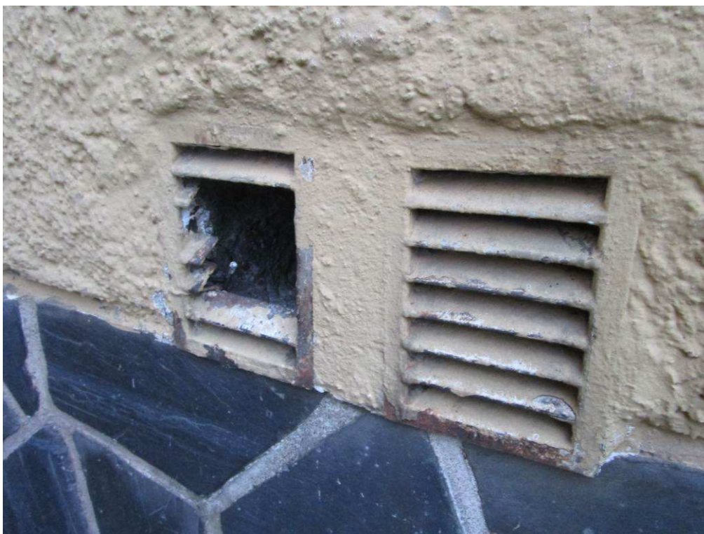
Kuva 6. Säleiköissä on jo alkavaa hilseilevää ruostumista
