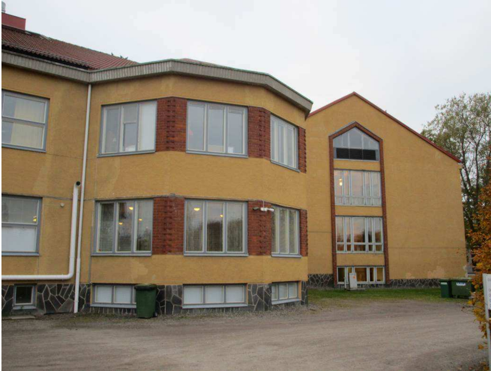
Kuva 1. Yleiskuvaa julkisivusta, julkisivut ovat keltaiseksi maalattua karkeaa roiskerappausta ja sokkelit ovat liuskekiviverhottuja
