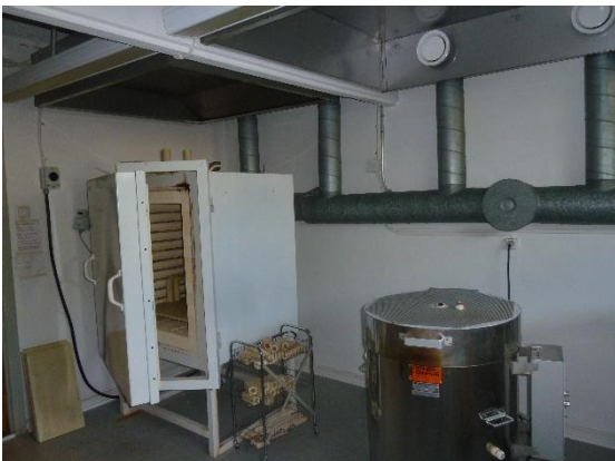
Peltikanavan kitti ei sisällä asbestia.
