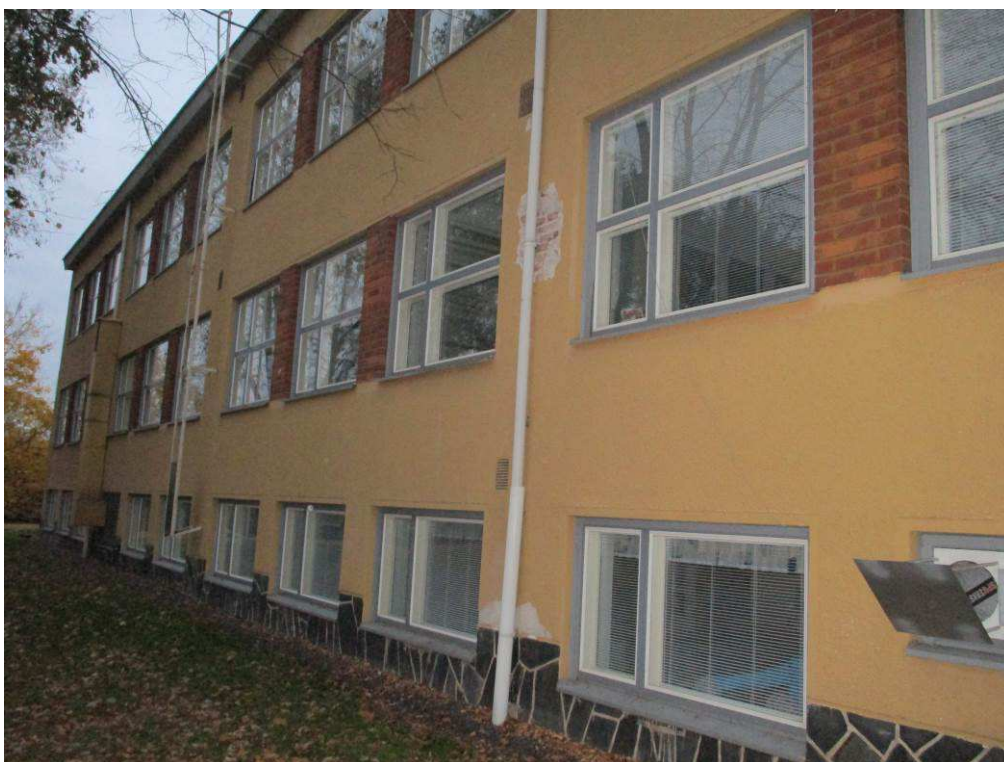
Kuva 18. Kuvan keskellä olevassa syöksytorvessa on jäätymisvaurio
