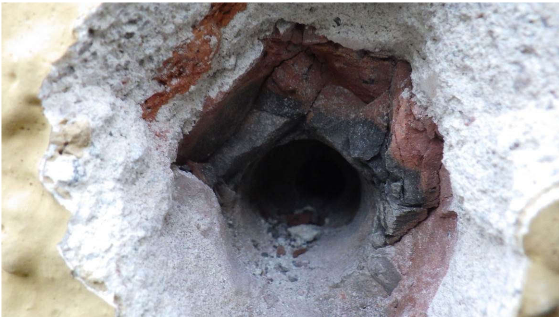
Kuva 9. Mustaksi poltettua tiiltä.
