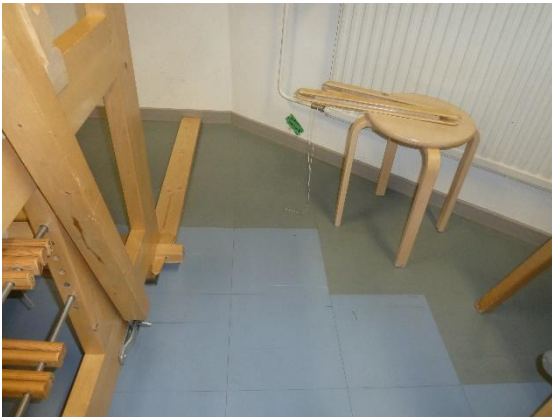
Vaalealla liimalla kiinnitetty 30 x 30 vinyylilaatta ei sisällä asbestia.
