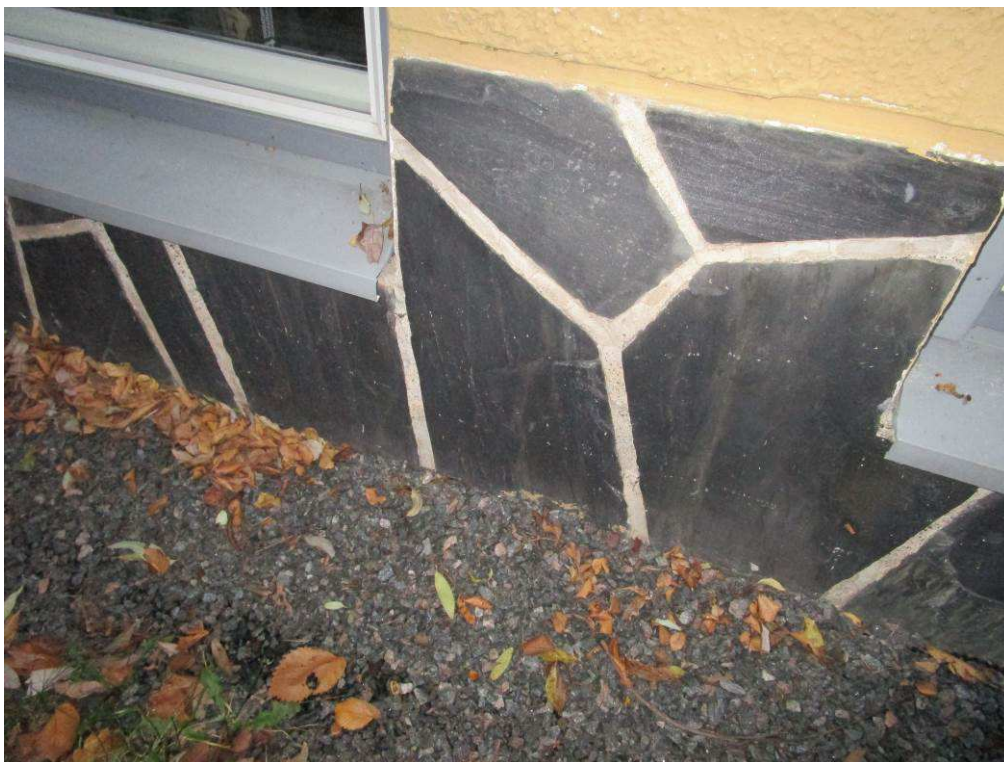
Kuva 11. Sokkelien liuskekivet ovat laajasti irti alustastaan
